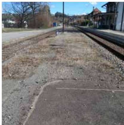
◀ Pistes de service de voies ferrées MuttENZ (CH-BL) et Montagny (CH-FR) - 2018 © M. van der Meer
