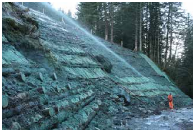
◀ Ensemencement hydraulique de la berge d'un chantier pilote renforcée par treillage bois et caisson en rondins végétalisés, Bex (CH-VD) - 13.11.2012 © P.-A. Frossard
